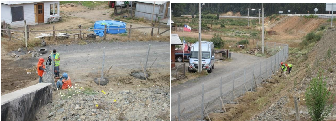
Instalación Cerco Perimetral Tramo A Sector II Calzada Derecha By Pass de Laraquete, el Pinar km: 46,960 – 47,025.
