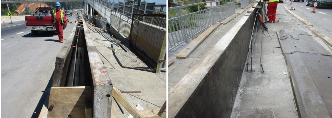
Instalación de Moldajes y Enfierradura Barreras Tipo F Tramo A Sector I Calzada Derecha km: 25,815.
